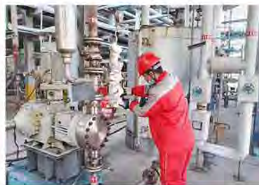
(图为生产运行中心员工为压力表做保温)
